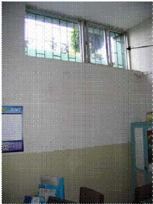
Ventana mal diseñada área abre menos del 25%
