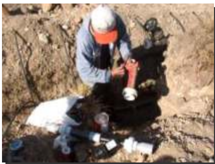
Foto N° 07: Instalación del arco del sistema de riego por goteo. Uchuypampa.
