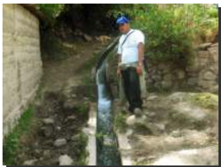
Foto N° 04: Evaluación de infraestructura mayor Secllas Alto - Huanta.
