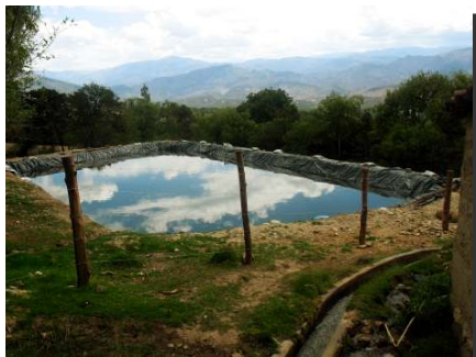
Foto N° 10: Reservorio de 1,000 m 3 de capacidad. Seccllas Alto - Huanta.
