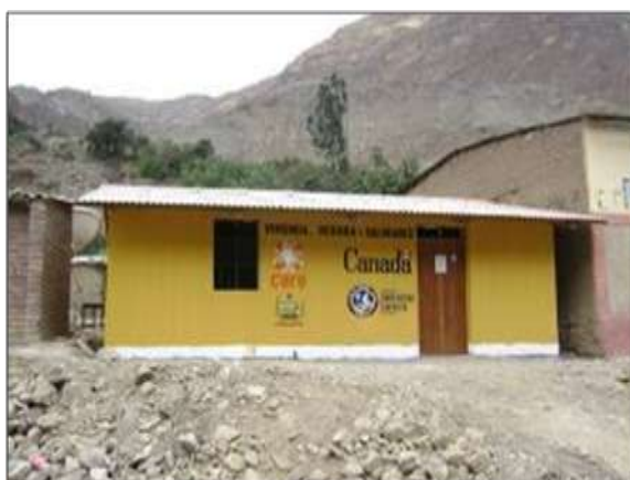
Vivienda de adobe reforzado en Ticrapo Huancavelica
