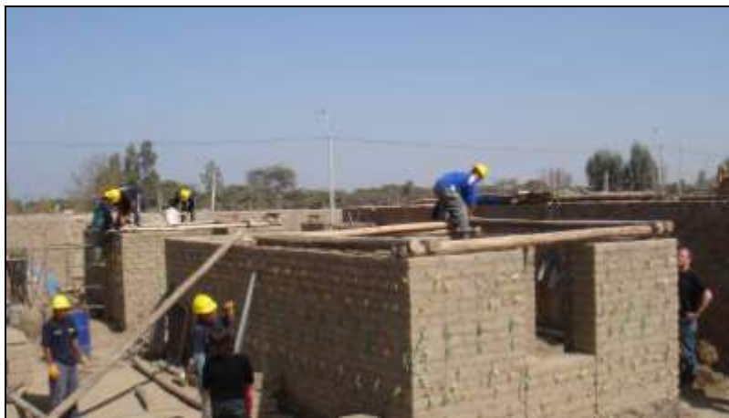
Modelo de vivienda en adobe reforzado en Parcona- Ica Programa GTZ-COSUDE. Julio 2008
